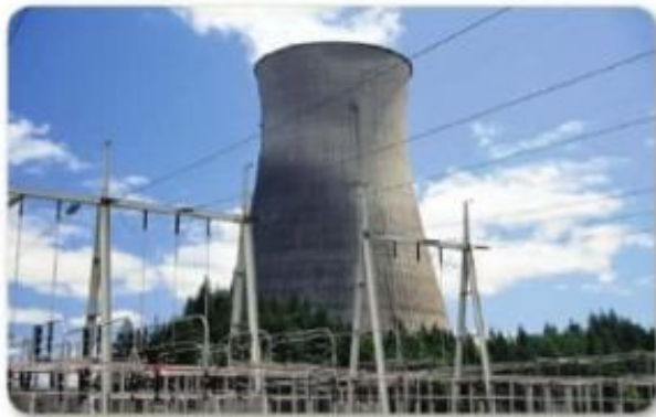
الشكل 10 تولّد محطة طاقة نووية كهرباء باستخدام الطاقة الحرارية الناتجة عن عملية الانشطار. هذا البرج الخرساني عبارة عن برج تبريد يعمل على إطلاق الحرارة المهدرة الناتجة عن تفاعل الانشطار.
