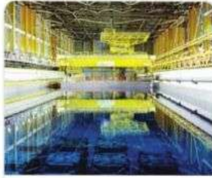
الشكل 16 تخزن الوقود المستهلك في حاويات مائية لتخزين في محطات توليد الطاقة النووية ويقر عالميا في برك تصفية حصيلتها الغرض.
