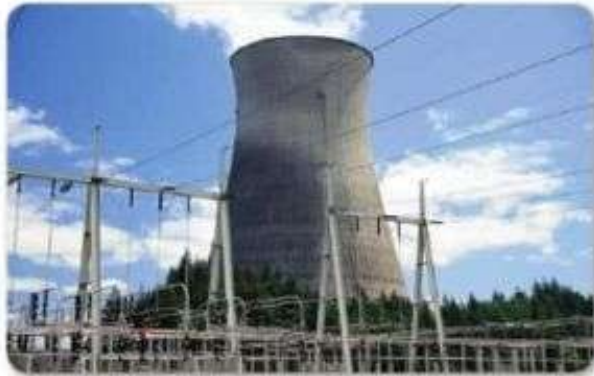
الشكل 10 تولد محطة طاقة نووية كهرباء باستخدام الطاقة الحرارية الناتجة عن عملية الانشطار. هذا البرج الخرساني عبارة عن برج تبريد يعمل على إطلاق الحرارة المهدورة الناتجة عن تفاعل الانشطار.
