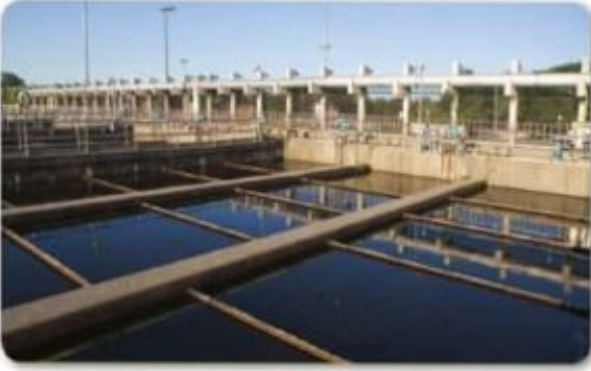
الشكل 26 في محطة لمعالجة الماء، تُزال المواد الملوثة من ماء الصرف الصحي للمحافظة على البحاري المائية نظيفة.
