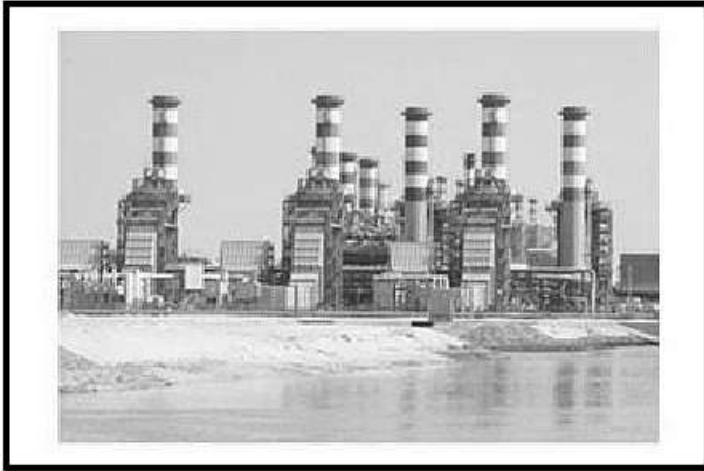
محطة تحلية مياه البحر
