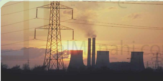
الكهرباء التي تنتجها محطة توليد الكهرباء هذه تنقل بعيداً عبر كابلات تتدلى من أبراج كهرباء عالية.
